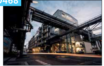
Building No. D468 / Gebäude Nummer D468
