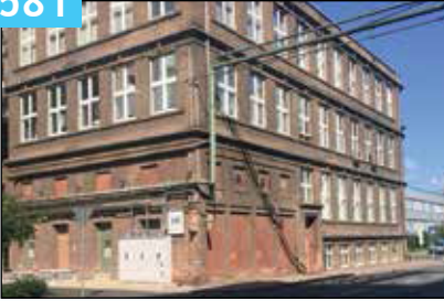
Building No. D581 / Gebäude Nummer D581
